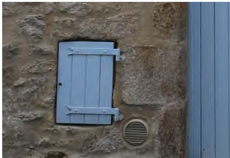
Avec la disparition de l'enduit, les moellons se sont altérés.
