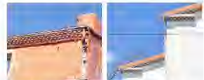
La génoise se déplace parfois de manière purement décorative pour agrémenter les façades un peu austères.
